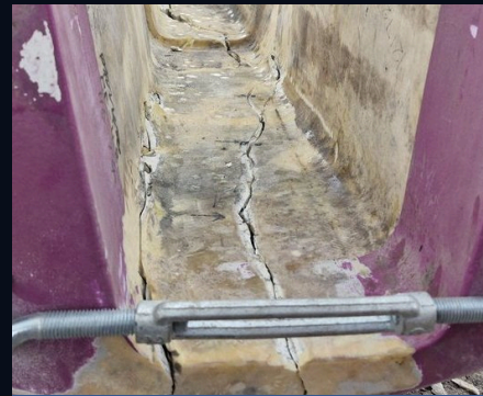
02 Longitudinal crack repair
